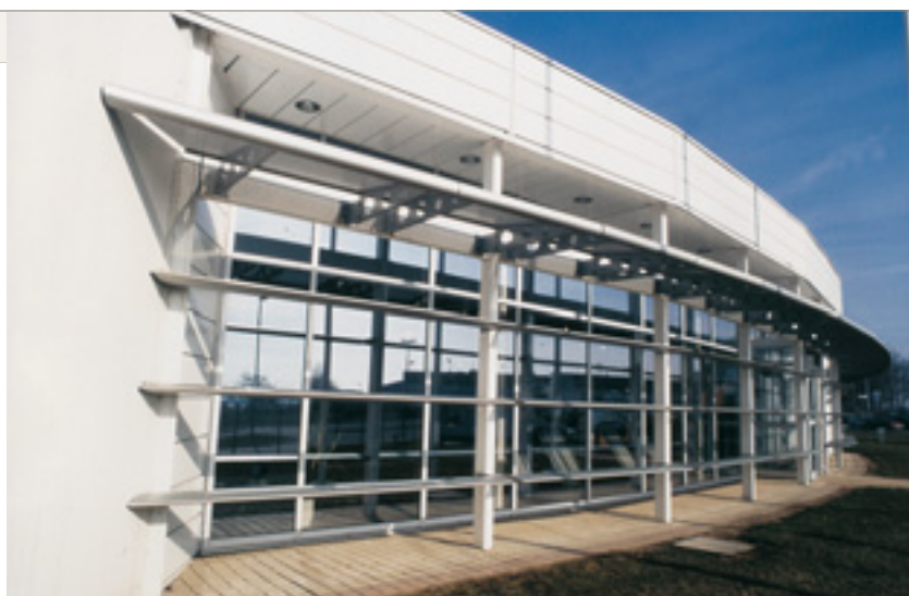
Vitrages latéraux équipés de pare-soleil intégrés.
