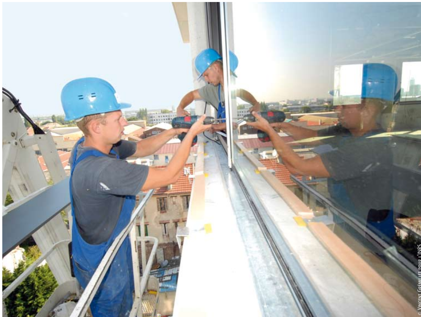
Pose de vitrages à faible émissivité, sur le tout nouvel immeuble Alma, à Gennevilliers, en région parisienne.
