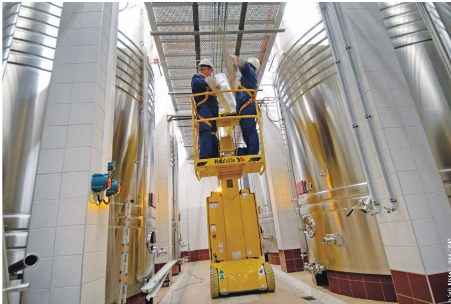
Le remplacement des lampes doit être effectué dès que le flux lumineux commence à baisser et il doit avoir lieu dans le cadre de la maintenance préventive.
