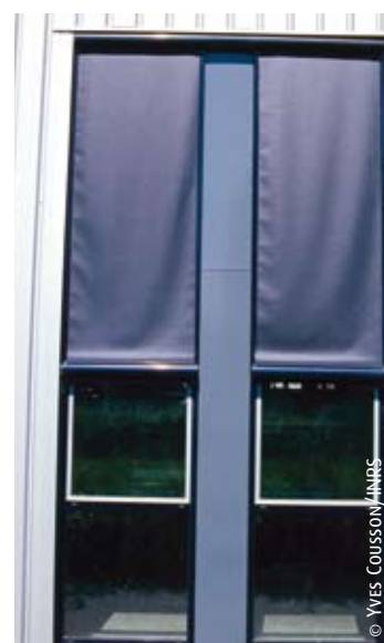
Les stores et autres dispositifs mobiles assurent une bonne protection solaire. Il est préférable de les installer à l'extérieur.
